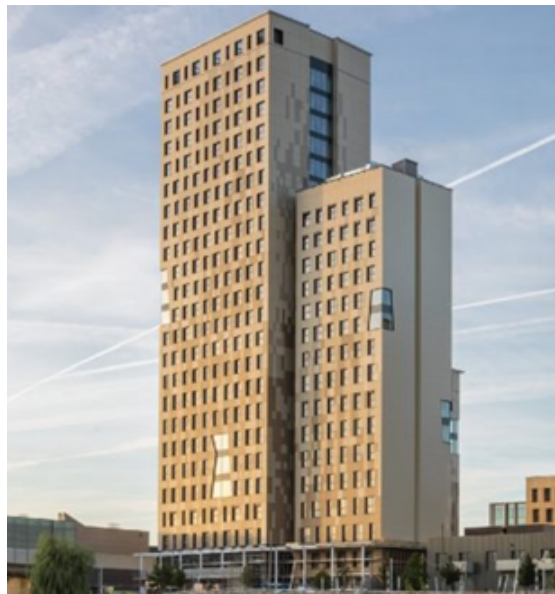
Fig. 1 : Edificio HoHo en Viena, Austria
