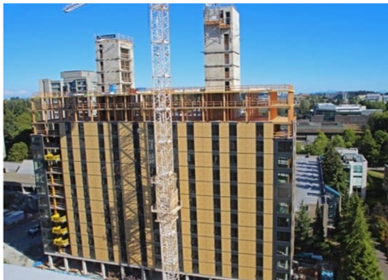
Fig. 4: Construcción del edificio
